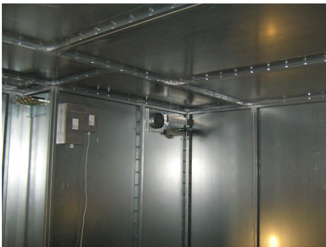
Assemblage des panneaux en acier épaisseur 2 mm
